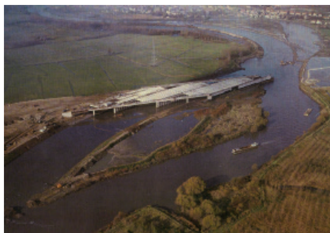
De bouw van de brug van de autostrade over de Nete
