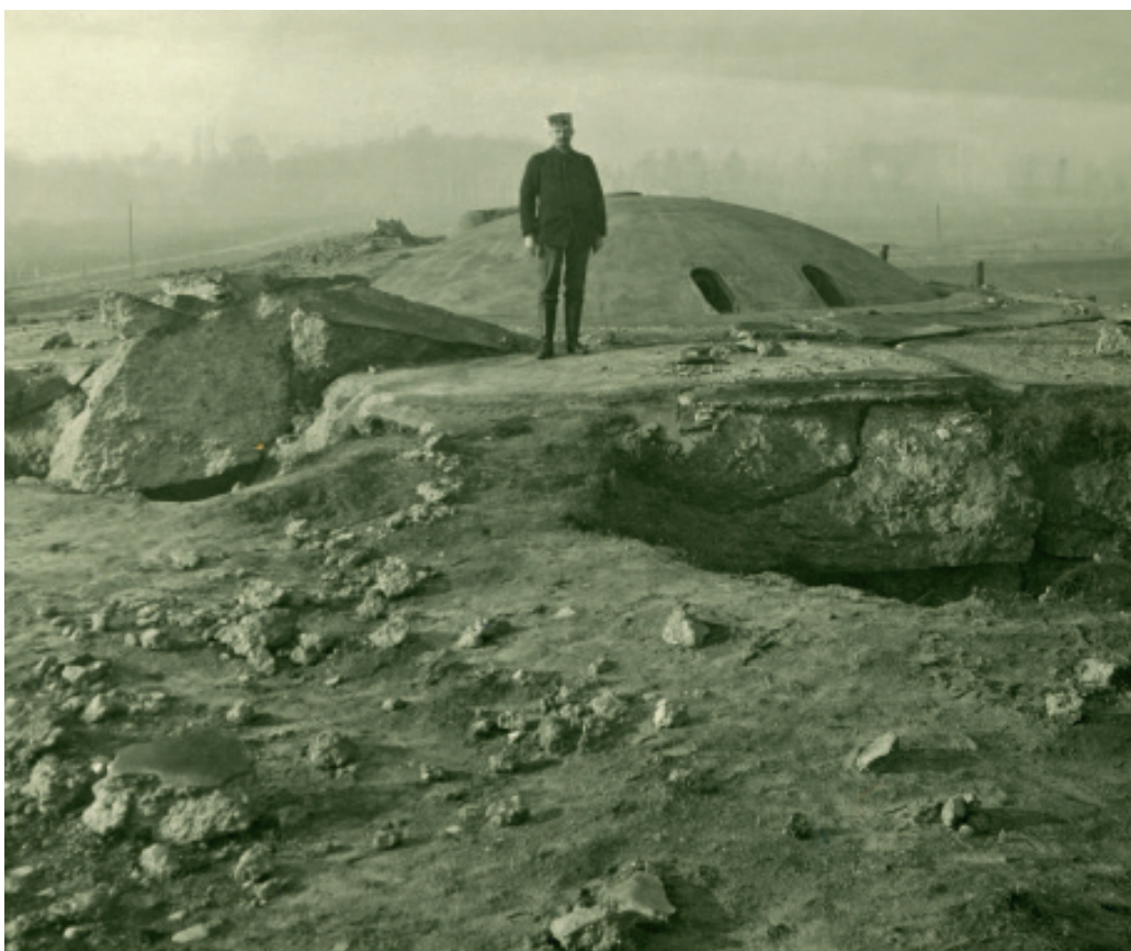
Een Duits soldaat laat zich fotograferen bij de inslag op de draaikoepel.
