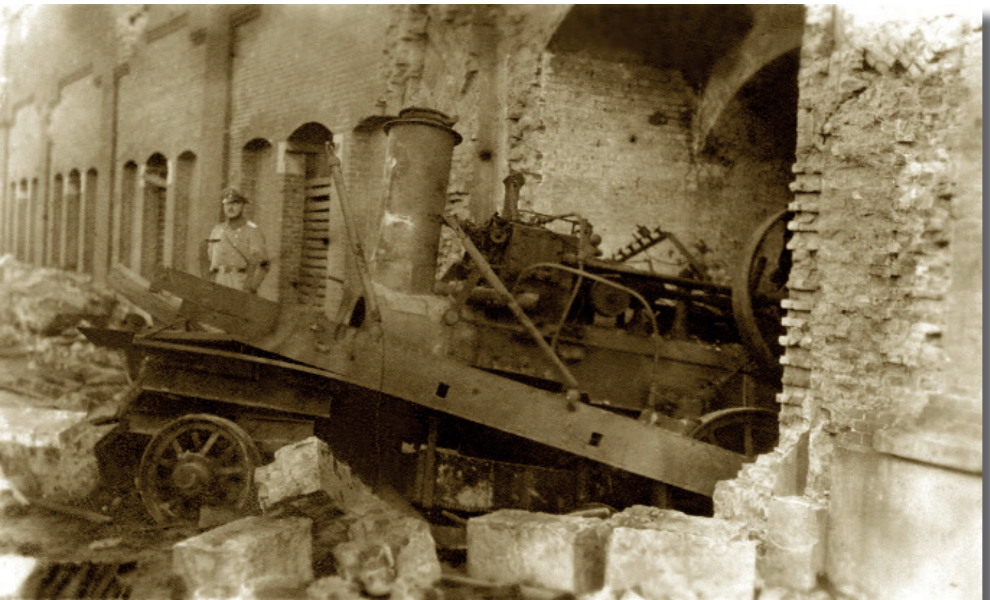
De stoommachine voor de elektriciteitsvoorziening vlak na de ontploffing in het hoofdfront.
