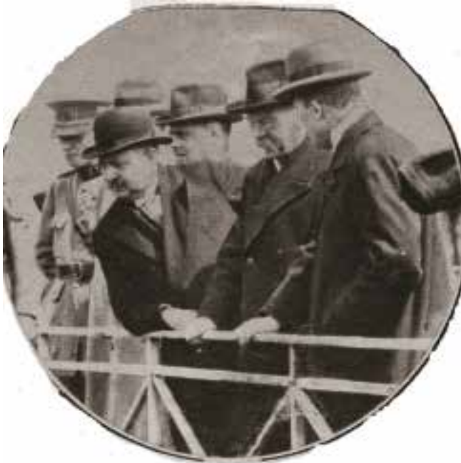
De nieuwe brugwerken te Waelhem werden de vorige week door Z.Exc. den Minister van Openbare Werken Van Caeneghem in oogenschouw genomen. De Minister slaat met belangstelling de nieuwe werken gade.
