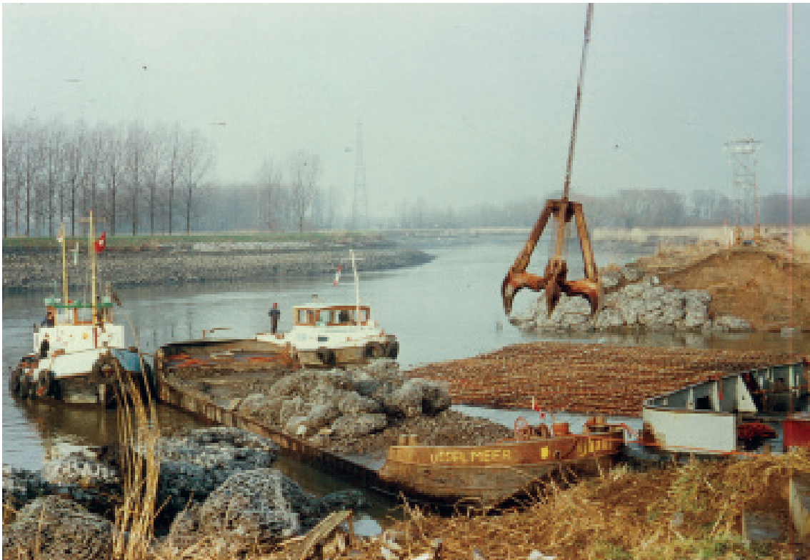
Een Nederlandse firma bij het herstellen van de bres in de dijk te Battenbroek
