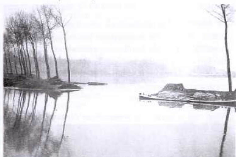
Bres in de dijk aan Polder de Koobeemden
