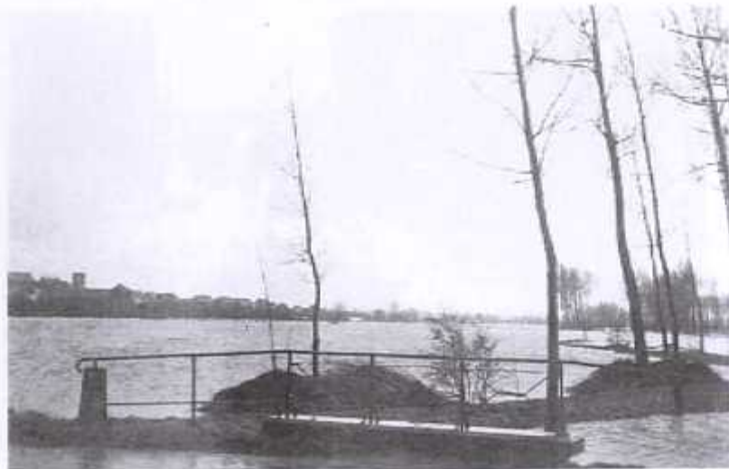
Bres in de dijk, ter hoogte van de Molenskiel.
