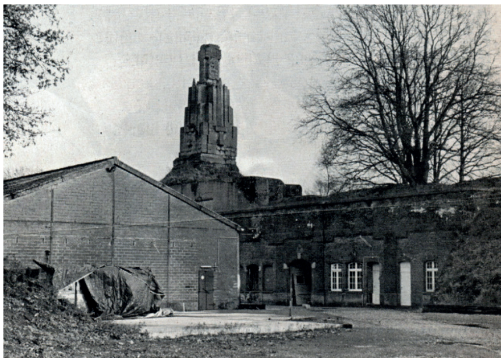
De civiele bescherming heeft haar nationale commandopost al sedert bijna dertig jaar in Walem ondergebracht. Het fort behoorde oorspronkelijk tot de tweede verdedigingsgordel van Antwerpen en dateert uit 1878. De mensen van de civiele zelf hebben het in Walem best naar hun zin. Foto: MJM
